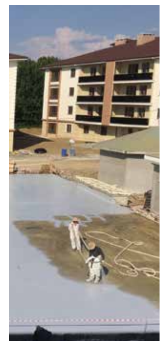
Foundation and curtain concretes Fundamenty i ściany betonowe
